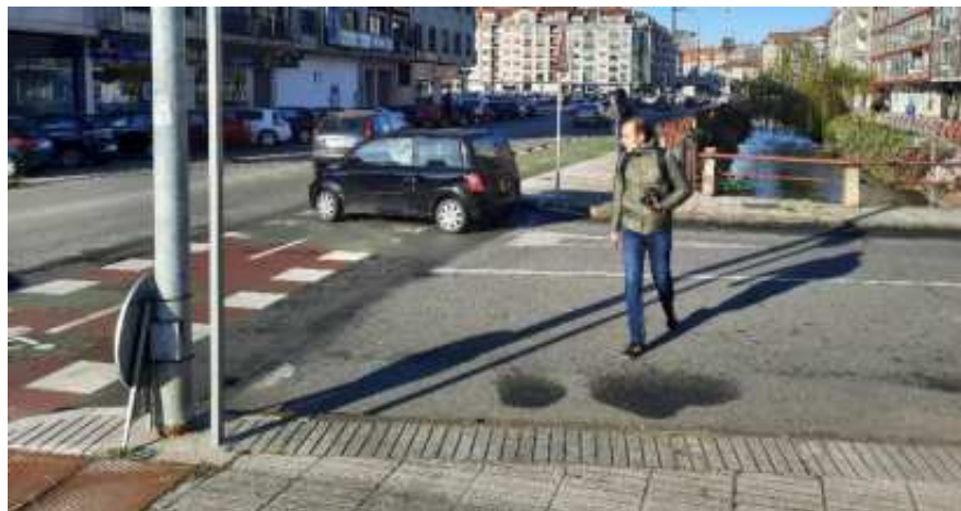
Foto 7.17 Discontinuidad peatonal en una intersección de Vilagarcía
