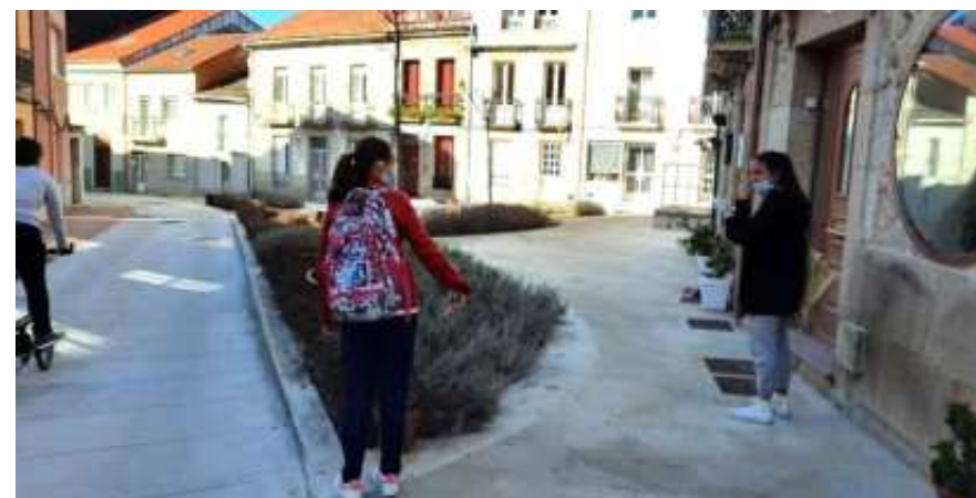
Foto 7.21 Calle y espacio estancial recientemente reformado en calle Vázquez Leis de Vilaxoán
