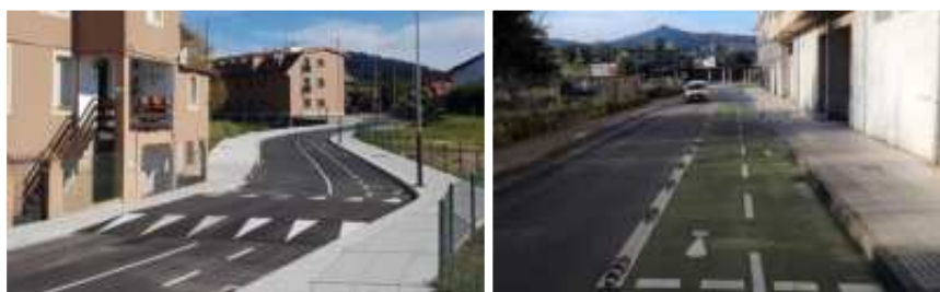
Foto 7.25 Carriles-bici en Rúa Freixo y Rúa Ramón Cabanillas
