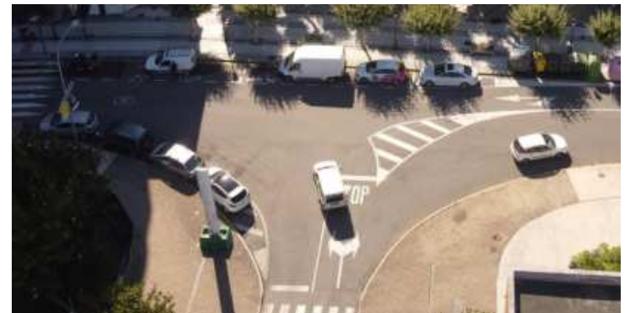
Foto 7.5 Aparcamiento irregular usando espacios residuales del tráfico por retranqueos excesivos o sobredimensionado del radio de giro de las aceras
