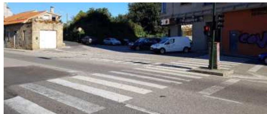
Foto 7.19 Cruce peatonal de longitud excesiva y aceras estrechas en una travesía urbana
